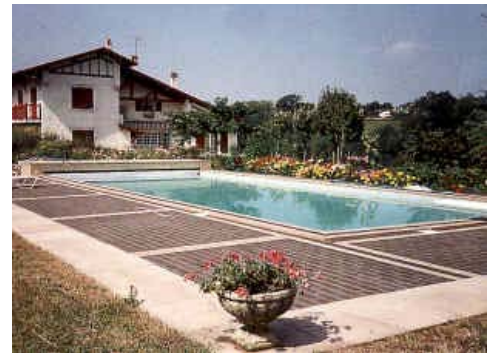
Piscina solar. Calienta su agua gracias a los rayos solares que inciden en las placas solares
