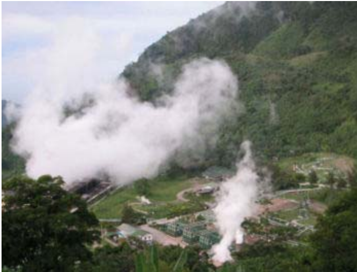
Planta de energía geotérmica en las Filipinas
